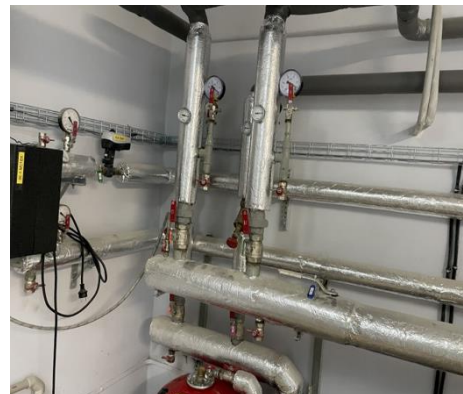
Veikta VUGD depo ēkas Daugavpilī pieslēgšana pie pilsētas centrālās apkures sistēmas
