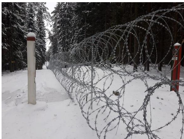
Pabeigta pagaidu žoga izbūve 36,94 km garumā
