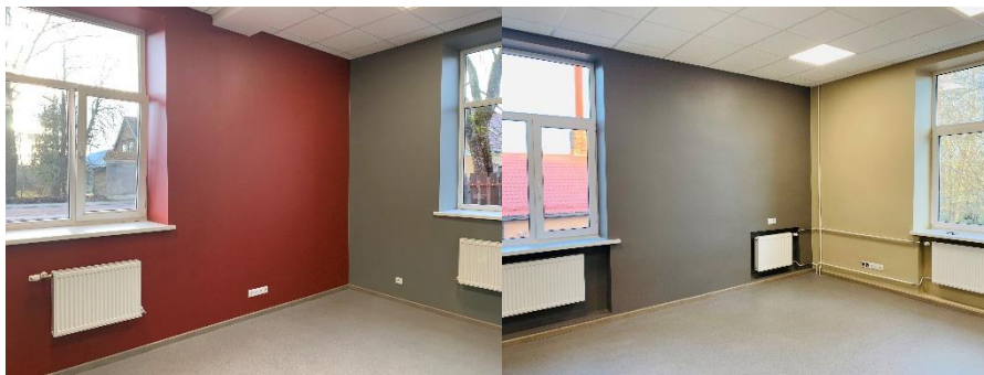
Veikti remontdarbi VUGD Kurzemes reģiona brigādes Kuldīgas daļas telpās
